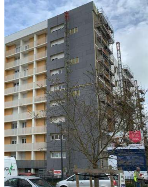
Rennes, résidence le Fleurigny, 118 logements en cours de rénovation
