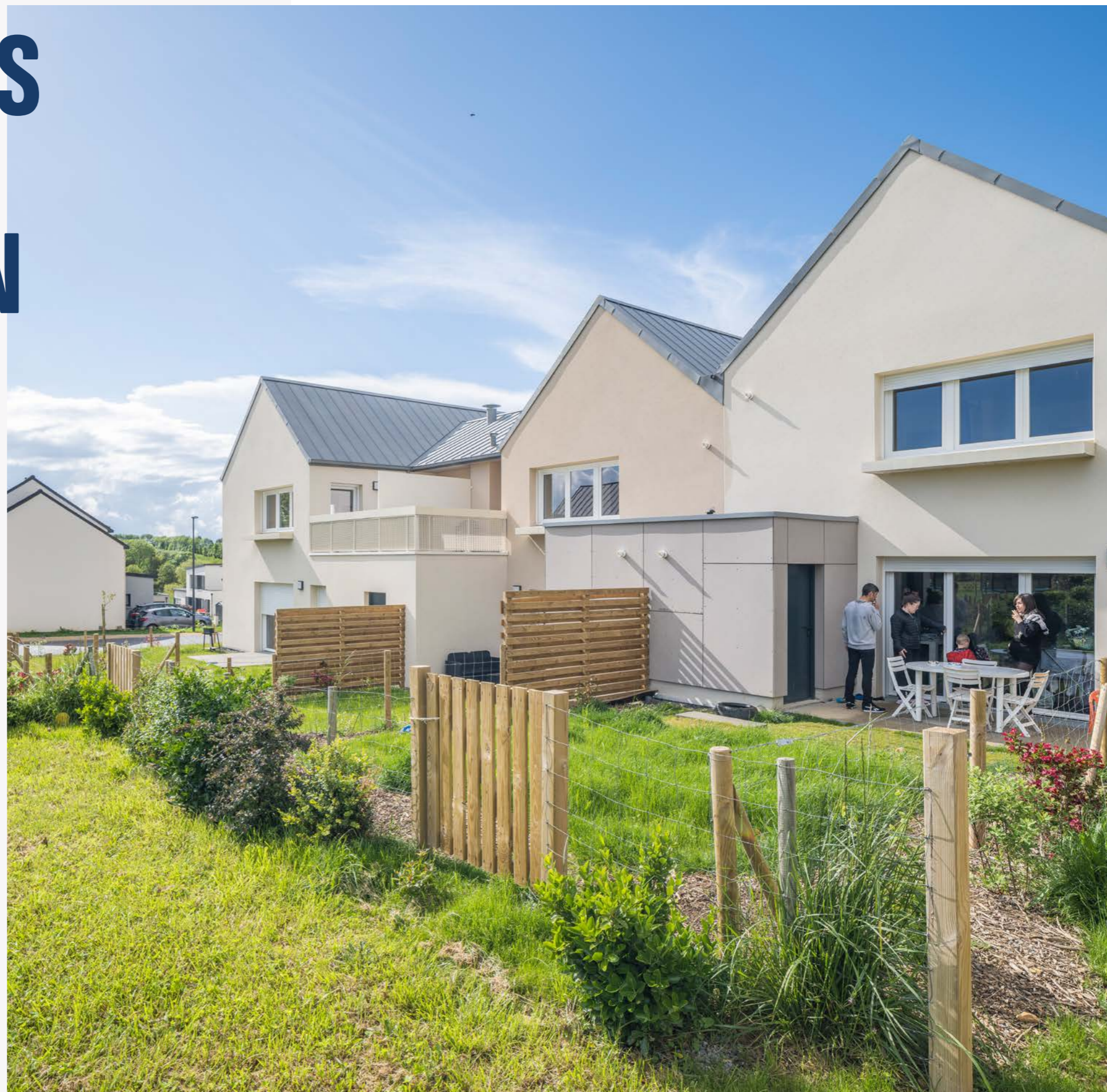
Janzé (35), résidence La Chesnaie - Architecte : Agence LHIA
