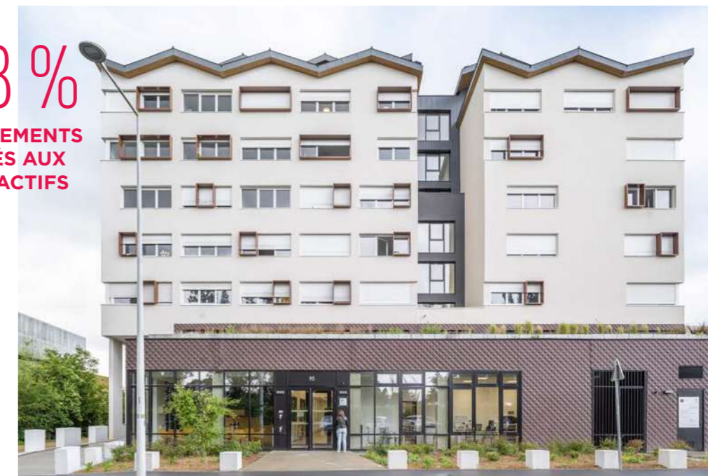
Rezé, Résidence Katherine Johnson, 61 logements pour étudiants et 50 pour jeunes actifs. Architecte : GDV Architectes
