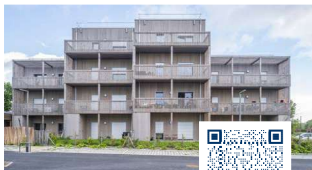
Résidence des Chênes Architecte : Tetrarc
