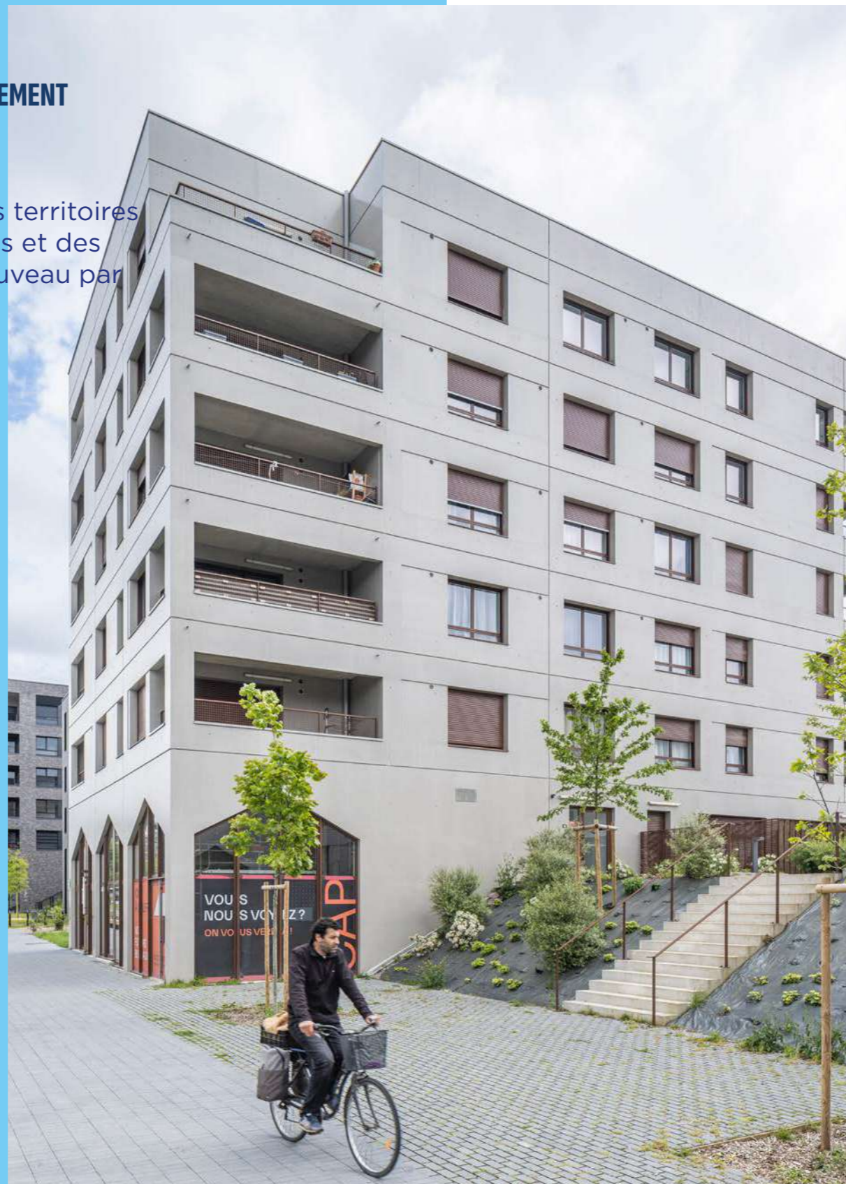
Saint-Jacques-de-la-Lande (35), L'Aviateur - a/LTA Architectes
